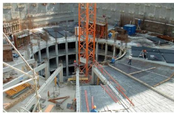
Une étanchéité a été installée entre le soutènement\* et le revêtement. Les tirants\* ont été détendus à la fin de la construction de l'ouvrage.
